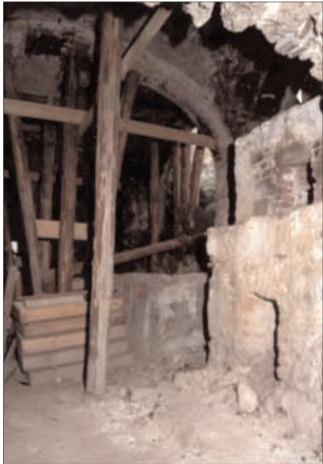
Fig. 16 - Ferentino, Chiostro del monastero di S. Antonio abate: forno, angolo sud-ovest (ASCNF, Rogiti del notaio Francesco Angelini, tomo IV, anni 1793-96, ff. 65r-119v). Foto precedente ai lavori di restauro degli anni 1998-99).
