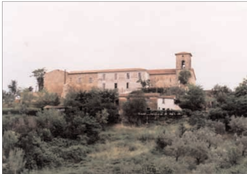
Fig. 15 - Ferentino, Chiesa di S. Antonio abate: il Monastero (lato sud) (FOTO G. COLLALTI, 1996).
