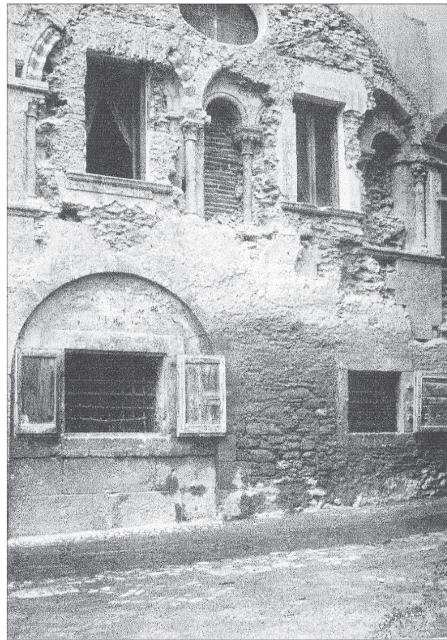
Fig. 11. Rinvenimento delle bifore medievali nella facciata del Palazzo Comunale di Ferentino durante i lavori di demolizione della torre civica. Cfr. M.T. VALERI, cit. , fig. 8.
